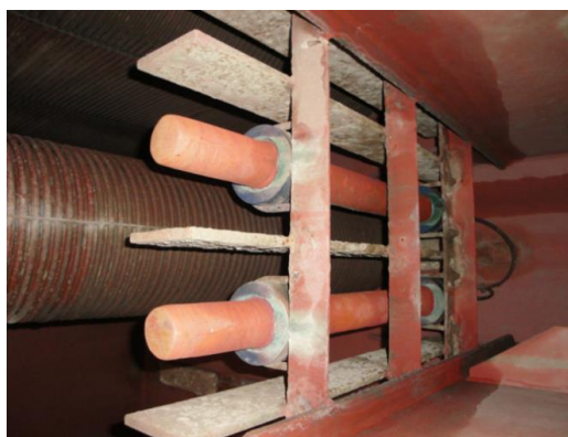
Рисунок 2 – Установка мідних стрижнів катодного захисту забортних теплообмінних апаратів
