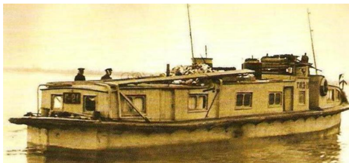
Рисунок 8 – Газогенераторный буксир: длина 21,7 м., водоизмещение 28 т., мощность 100 л.с., экипаж – 4 чел, 1935 г.
