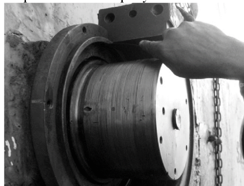
Рисунок 3 – Зруйнований підшипник ковзання шпора стріли суднового палубного крану Hagglunds
