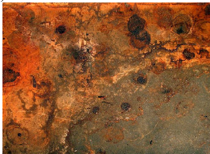
Рисунок 1 – Ржавчина – простейший вид коррозии
