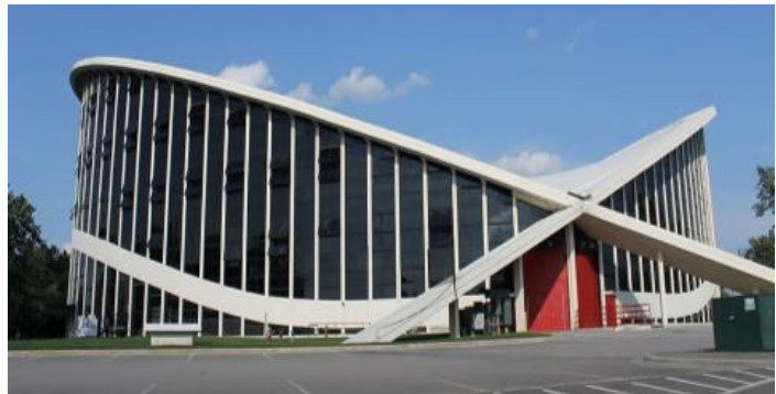
Рисунок 2 – Большепролётный комплекс с навесным вантовым перекрытием
