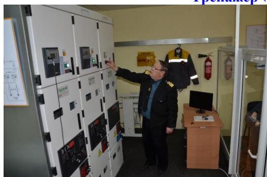
Лабораторія-тренажер з експлуатації суднового високовольтного електрообладнання
