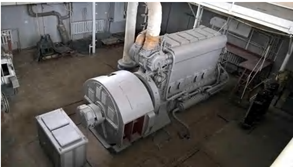
Дизель-генератор з дизельним двигуном 6ЧН25/34
